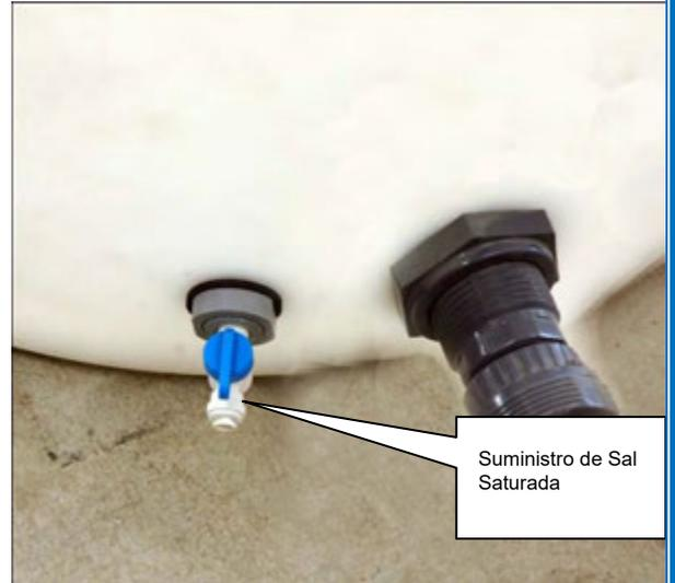
Instale el suministro de agua del Alimentador de Sal Saturada a la línea de retorno de la piscina utilizando tubería de 1/2 pulgada.
